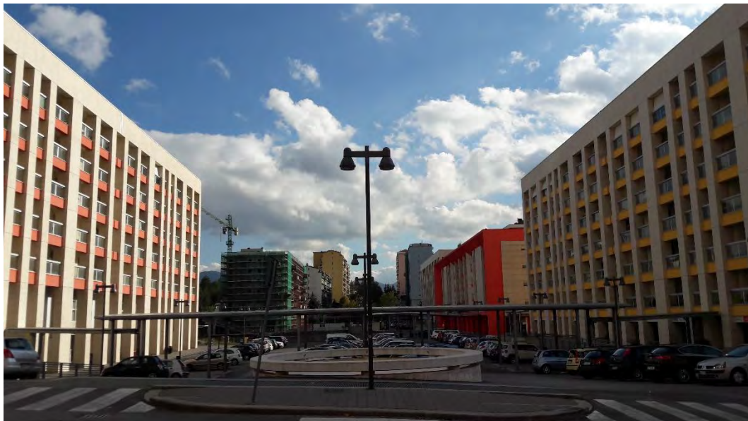
Figura 4.6 Foto di Piazza della Costituzione italiana con gli edifici realizzati e quello in fase di costruzione
